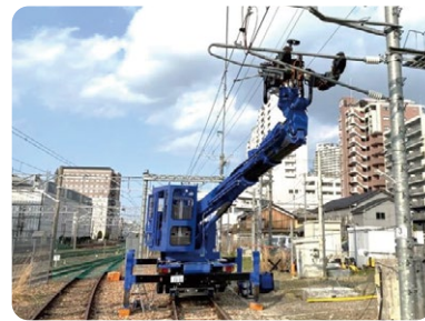
多機能鉄道重機
